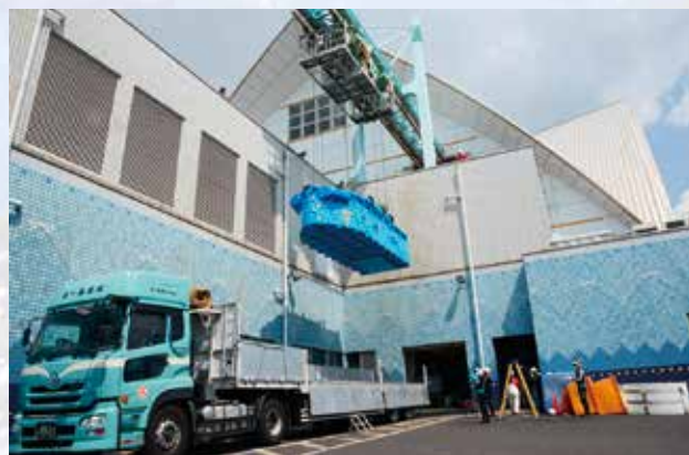
専用のクレーンを利用して建物の3階からトレーラーの荷台へ降ろされる専用の輸送容器（長さ7m 水量18t）。
