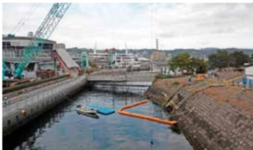
大型クレーンでイルカ通路止水用鉄板を移動し固定します
